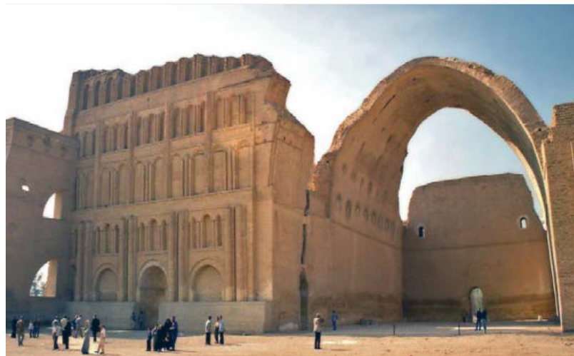
1. Ctesifonte, Arco funicolare in mattoni crudi di 40 metri di altezza realizzato nel IV secolo d.C. vicino a Bagdad in Persia (IRAN).
