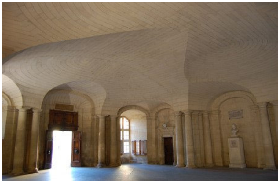
7a. L'Hôtel de Ville della città di Arles. Vista generale della volta in pietra del vestibolo progettato da Jules Hardouin-Mansart (1646-1708), nipote e allievo di François Mansart (1598-1666), e di Michel Mansart.
