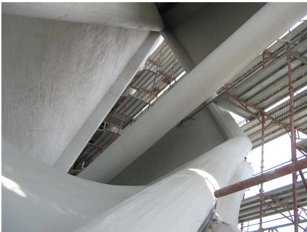
32. Lavori ultimati con l'applicazione della protezione acrilica.
