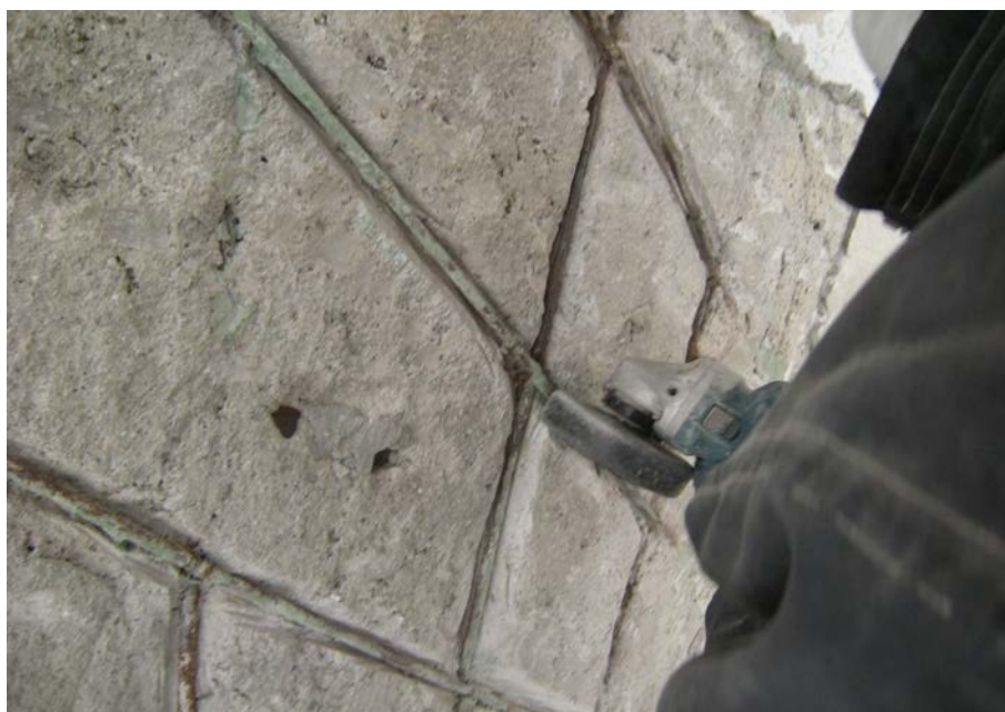
25. Scarifica e liberazione manuale dei ferri di armatura da una volta sottile.
