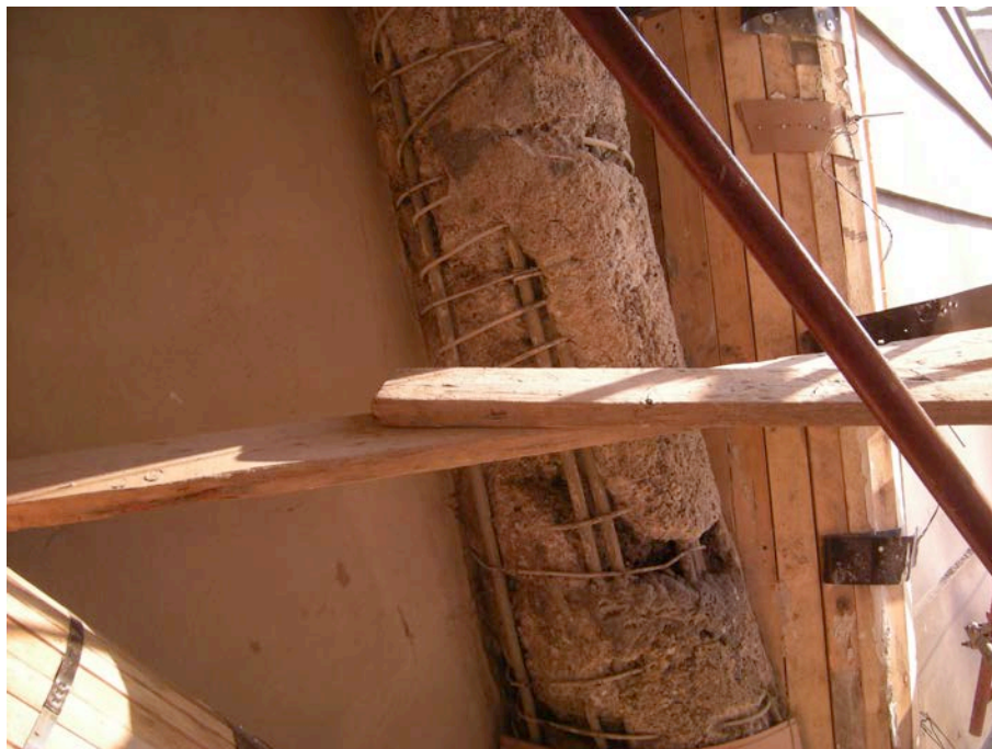
4. Pilastro in c.a. con una zona completamente priva di calcestruzzo. Si tratta di un difetto congenito determinato dalla difficoltà di gettare calcestruzzi poco fluidi. All'epoca della realizzazione della chiesa, nella prima metà degli anni sessanta, infatti, non era disponibile il calcestruzzo preconfezionato. Il conglomerato veniva prodotto in opera, di solito senza uno studio delle curve granulometriche e senza ricorrere agli additivi superfluidificanti accentuando, pertanto, il rischio di segregazione del calcestruzzo durante il getto.
