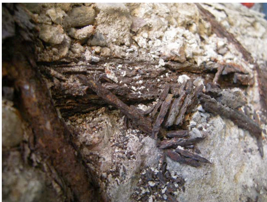
3. Completa corrosione dei ferri di armatura in corrispondenza della sezione di attacco tra volta sottile ed elemento portante in c.a.
