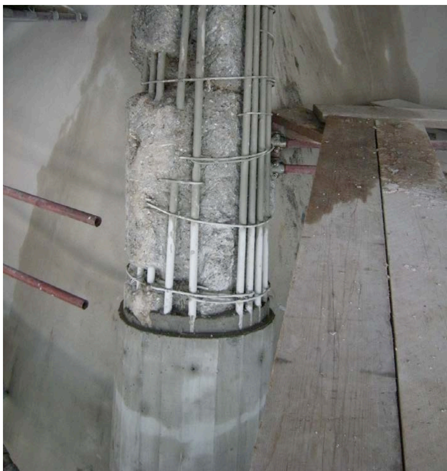
18. Porzione di pilastro ricostruita (in basso) e zona superiore pronta per essere cassata.
