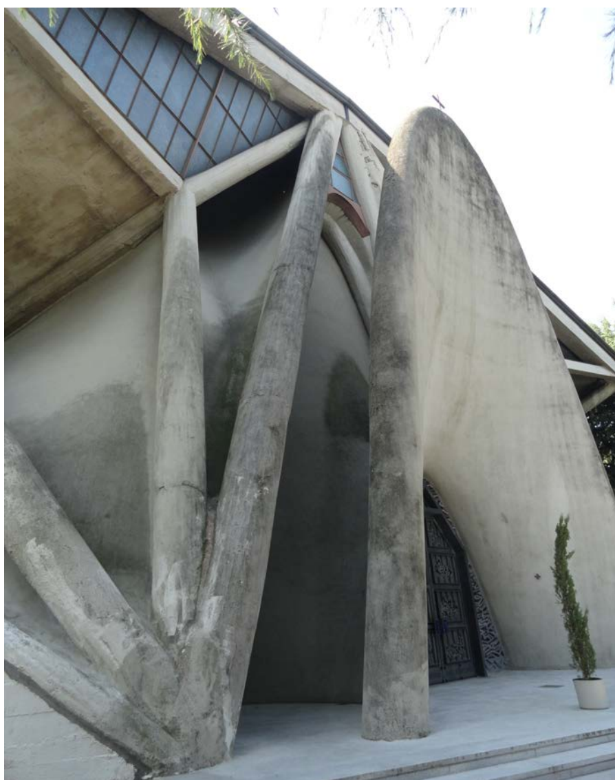
7. Deposito di particolato atmosferico sulle volte (a sinistra) e colonizzazioni biologiche in corrispondenza della zona sommitale del portale di ingresso alla chiesa.
