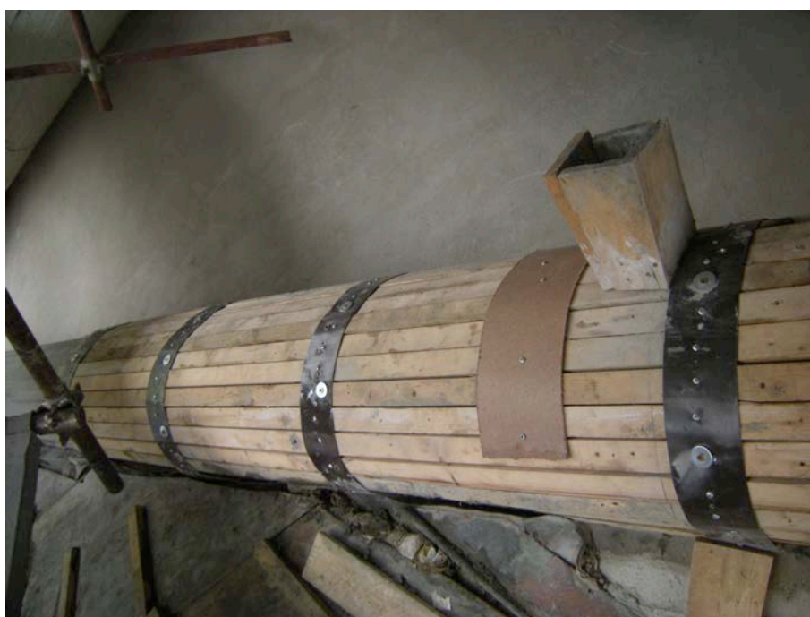
16. Il cassero con tavole di legno confinate con lamine metalliche e provvisto sulla parte alta dell'imbuto attraverso il quale viene gettata la malta colabile.
