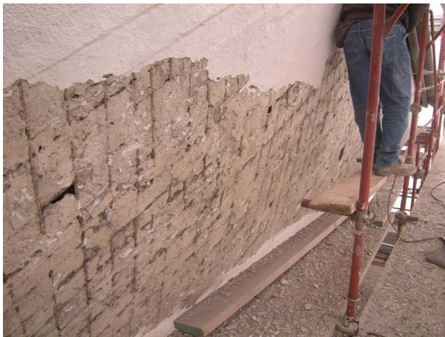
23. Distacco della protezione superficiale applicata nei precedenti interventi e ferri in vista sebbene in buono stato sulla parete sud-ovest della chiesa.
