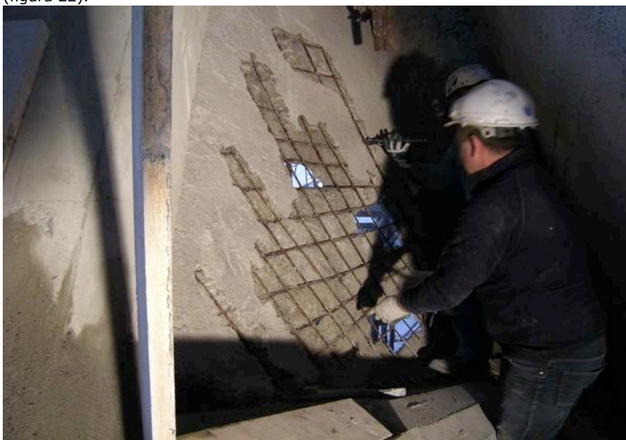
22. Corrosione dei ferri in una volta sottile con espulsione del copriferro. Si noti che in alcuni punti la sezione della volta è totalmente mancante del conglomerato cementizio.
