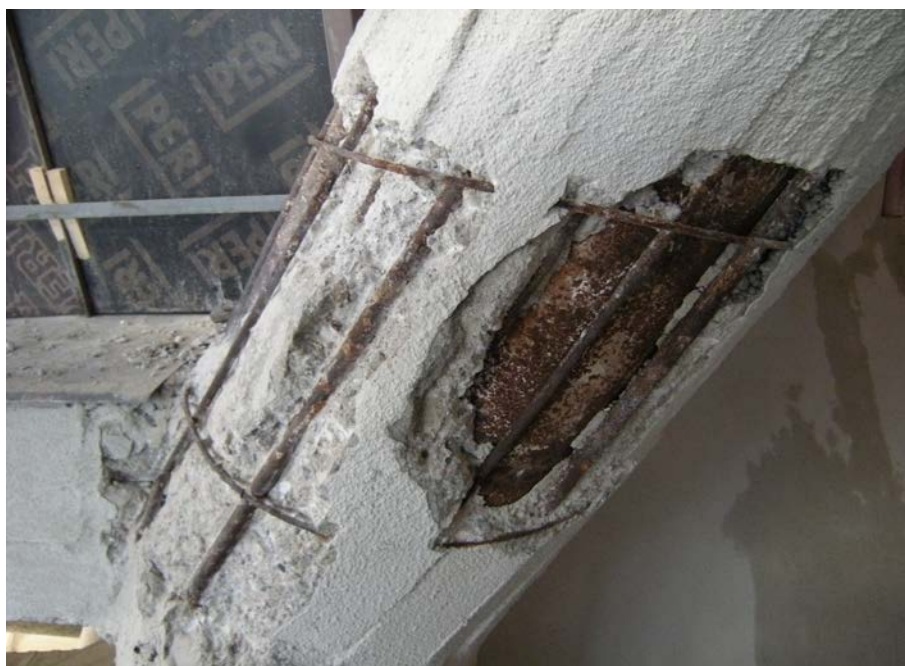
6. Elemento tubolare in acciaio annegato nella porzione sommitale di un puntone inclinato.
