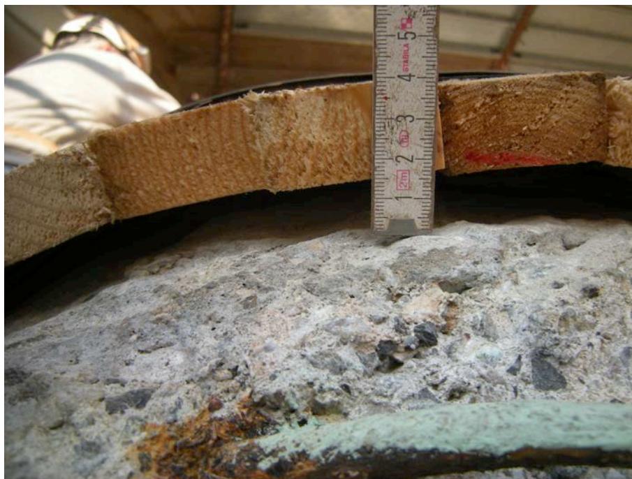
15. Il cassero sollevato dal substrato in calcestruzzo per almeno 15 mm.
