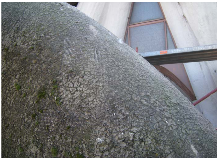
8. Particolare della membrana polimero-cemento sulla zona sommitale del portale di ingresso. Si noti la presenza di muschi sulla superficie del rivestimento protettivo e il degrado della stessa membrana consistente in una severa asportazione di materiale che mette in risalto la rete di armatura in fibra di vetro annegata al suo interno.
