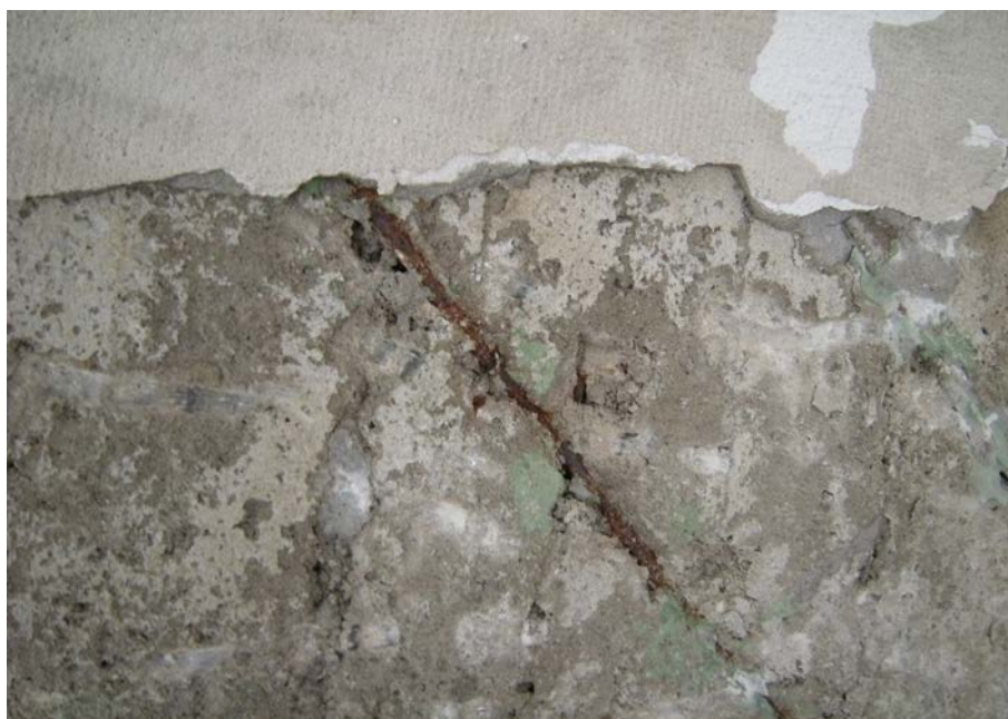
9. Particolare di una zona del portale. Si noti come la mera applicazione sul ferro della vernice protettiva (di colore verde nella foto) non abbia impedito al ferro si corrodere.
