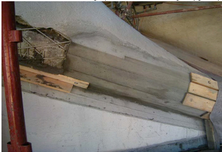
27. Ricostruzione con malta tixotropica delle volte sottili completamente crollate. Dopo l'applicazione della malta tixotropica la superficie è stata stampata con tavole di legno per ottenere l'originale facciavista.
