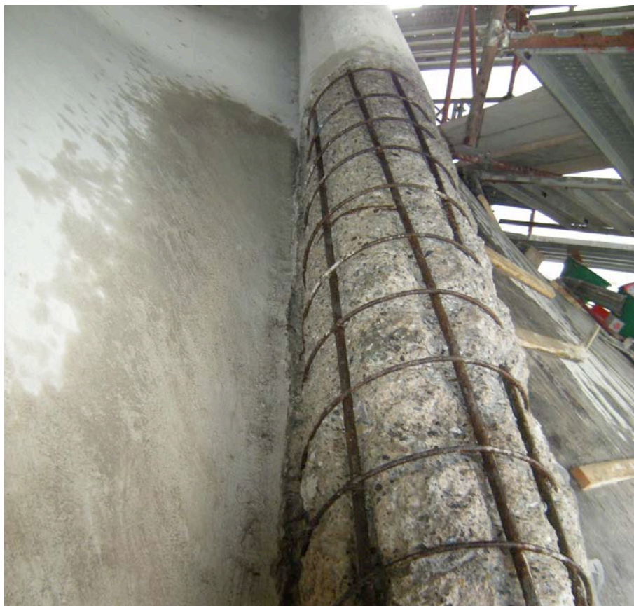
11. Elemento sub-orizzontale in c.a. dopo la scarifica e la liberazione dei ferri il cui perimetro risulta libero per poter effettuare le operazioni di rimozione della ruggine.
