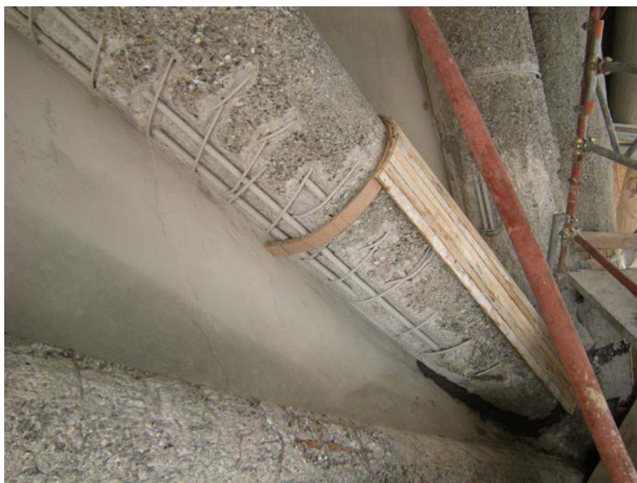
14. Posizionamento della fascia in faesite e parziale montaggio del cassero con tavole in legno.
