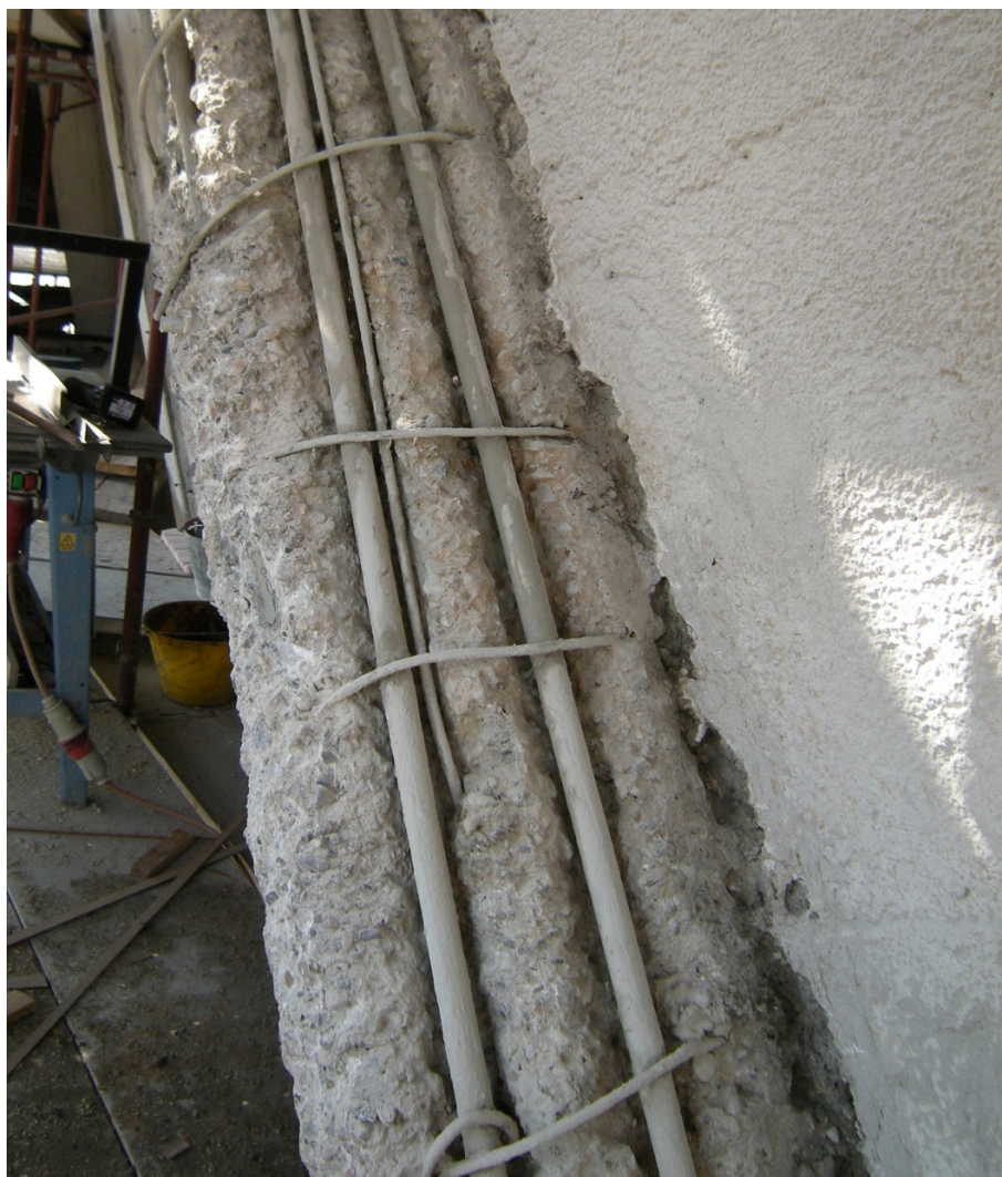
13. Elemento in c.a. dopo la scarifica, la liberazione, pulizia e protezione dei ferri pronto per la ricostruzione con malta colabile.
