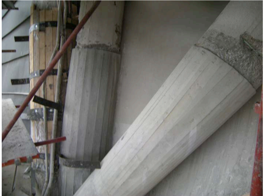
19. Tre elementi in c.a.: il primo a sinistra è stato appena ricostruito con malta gettata entro cassero; i restanti due sono stati già disarmati.
