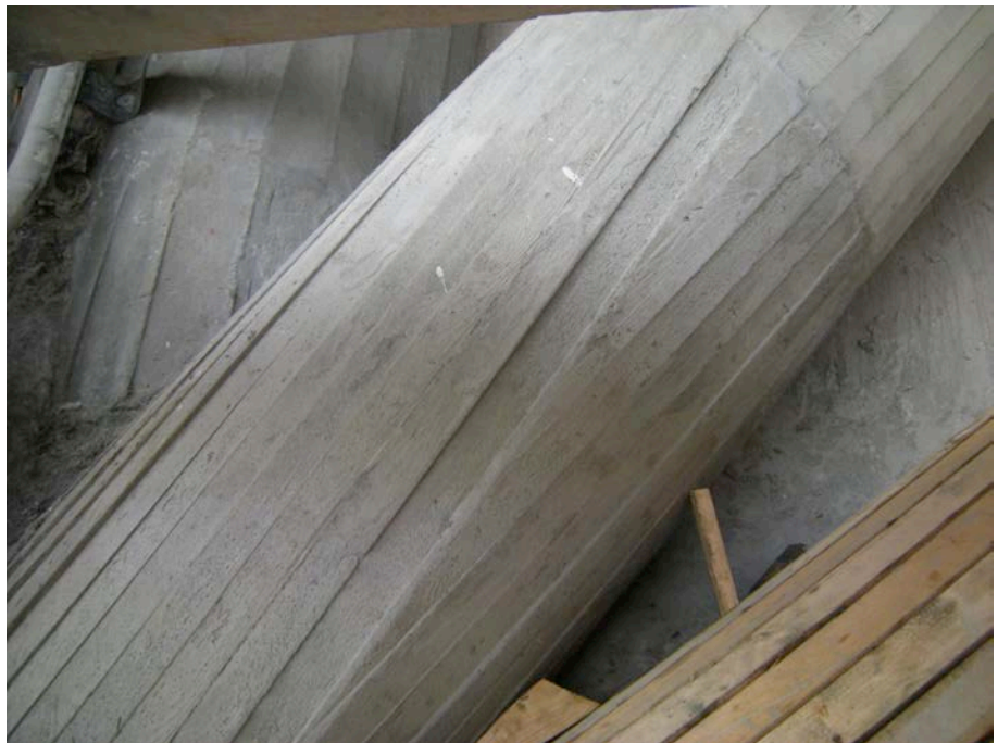
20. Particolare del facciavista di un elemento sub-orizzontale dopo la ricostruzione con malta colabile.
