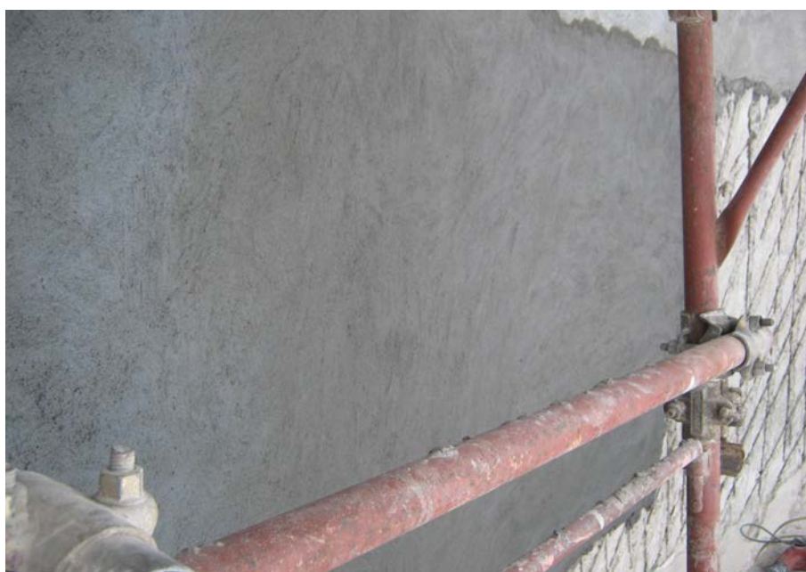
26. Ricostruzione della volta con malta tixotropica.
