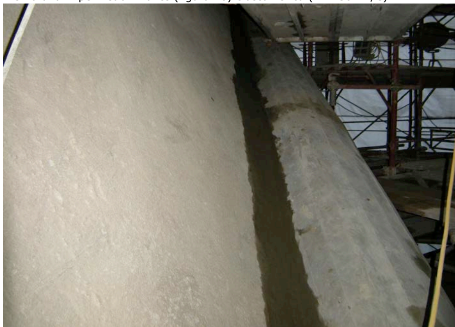
28. Impermeabilizzazione dell'attacco volta sottile-struttura portante con sigillante poliuretanico e membrana elastomerica.
