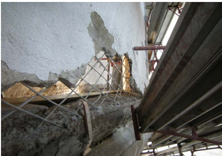
21. Completo collasso della sezione di una volta sottile in corrispondenza dell'attacco con un elemento portante.
