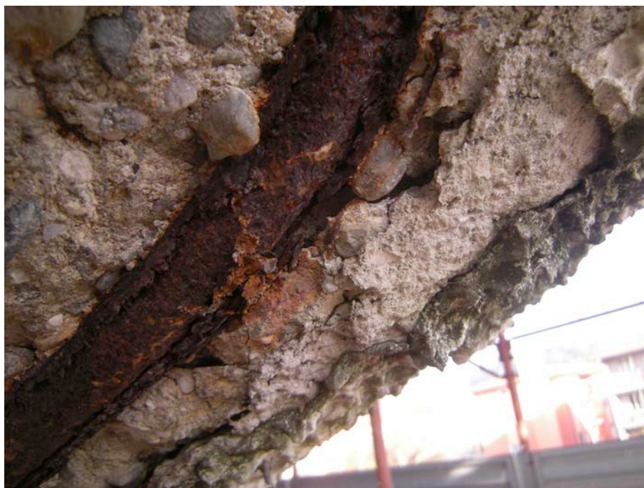
2. Particolare dell'attacco della volta alla struttura portante. Il rivestimento protettivo (sulla destra) si è distaccato esponendo il ferro d'armatura alla corrosione con conseguente espulsione del calcestruzzo.
