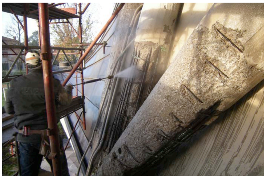
10. Idroscarifica di un elemento portante in calcestruzzo.
