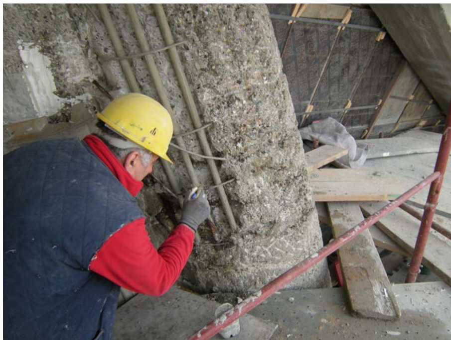
12. Applicazione a pennello del protettivo per ferri (EN 1504-7).
