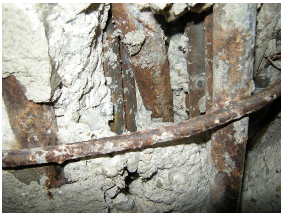
5. Particolare di un pilastro con una zona congestionata di ferri di armatura non completamente annegati nel conglomerato cementizio.
