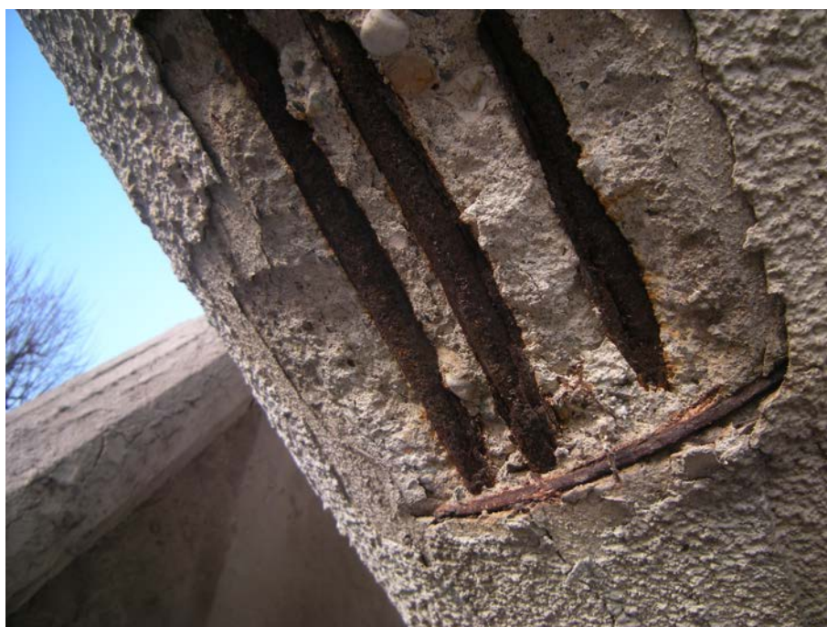
1. Puntone in calcestruzzo armato con area parzialmente interessata da ferri corrosi ed espulsione del calcestruzzo del copriferro. L'originale struttura in c.a. è rivestita con una membrana a tessitura grossolana applicata negli anni '80 nel corso del primo di intervento di restauro.
