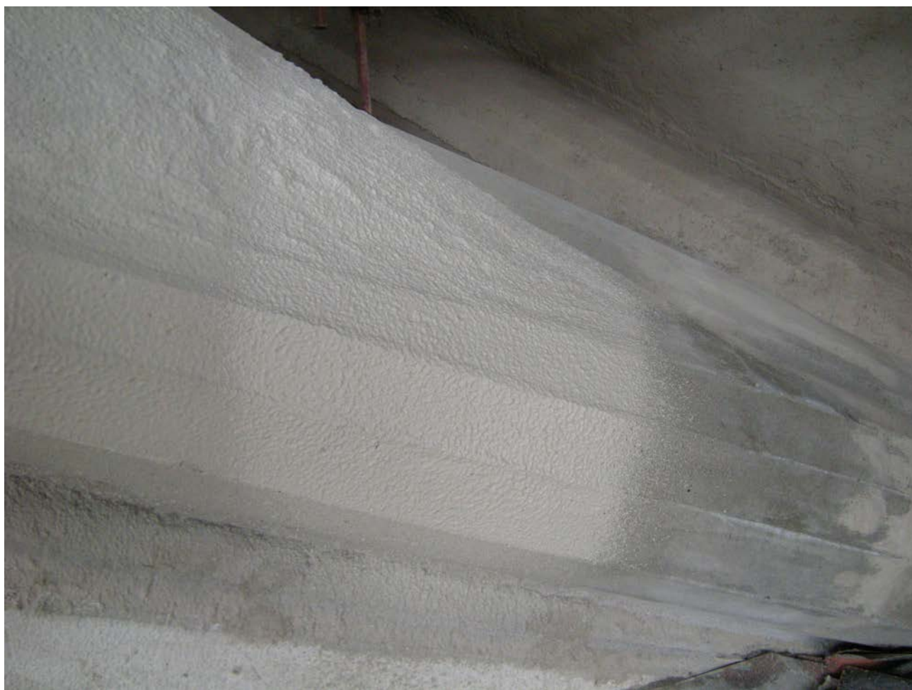
29. Applicazione della rasatura (al centro) su un elemento in c.a. ricostruito per uniformare la tessitura a quella della membrana (sulla sinistra) applicata nei precedenti interventi e successiva verniciatura con protezione acrilica colorata.
