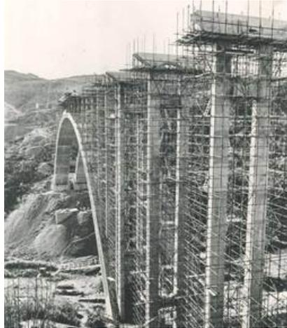
*Figura 3- Costruzione dei pilastri che sorreggono l'arco del ponte sul fiume Aglio*
