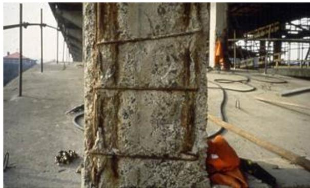
*Figura 4- Tipica corrosione dei ferri di armatura nei pilastri del Ponte sul fiume Aglio*
